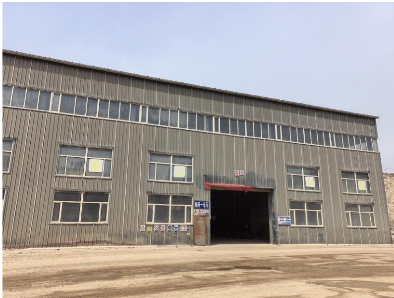
照片3-11 1号破碎站
