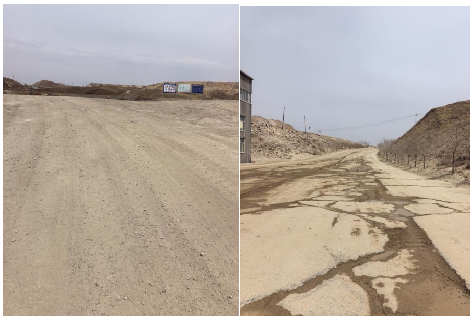
照片 3-23 一采区矿区道路
