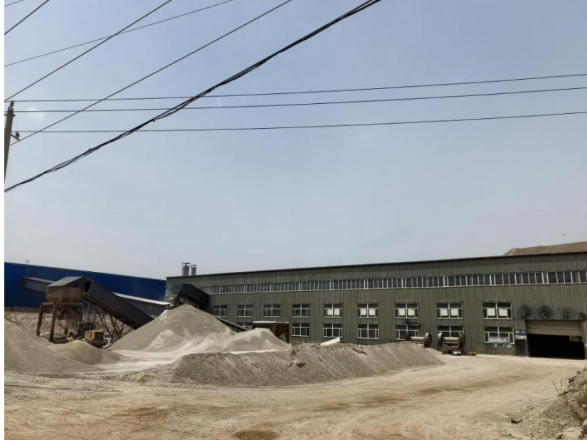
照片 3-12 2 号破碎站
