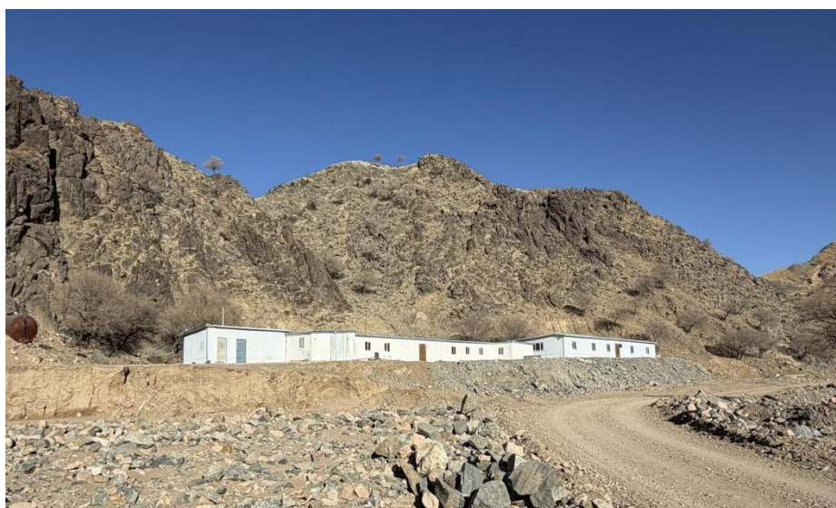
照片 1-23 废弃办公生活区
