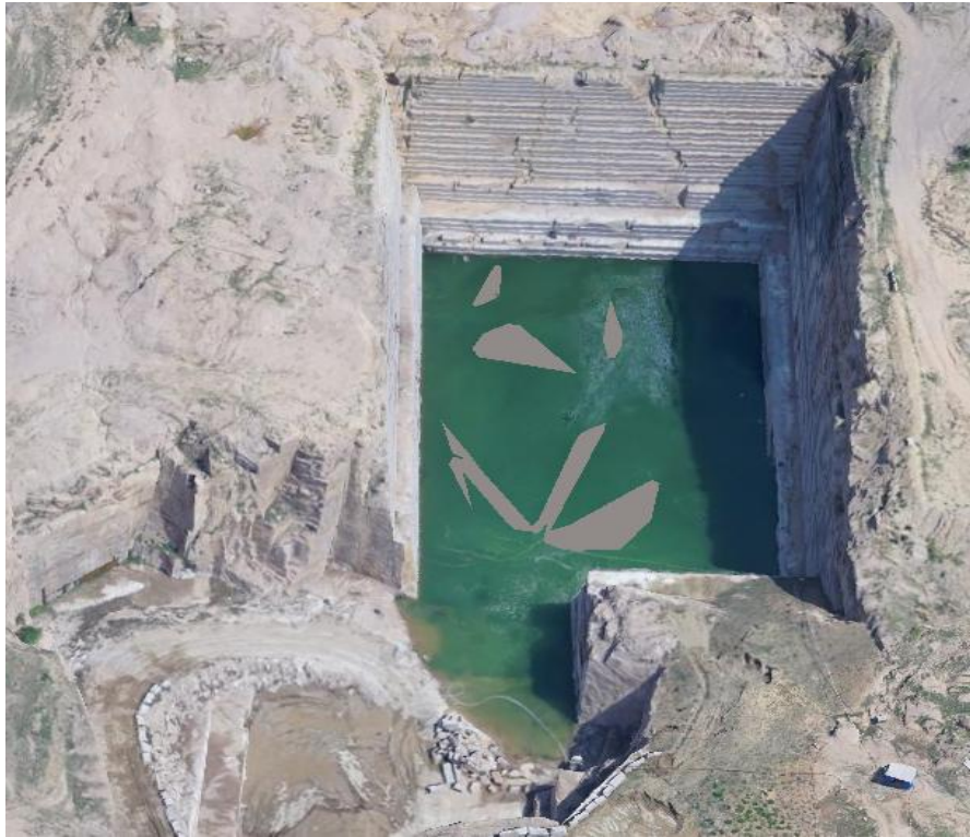
照片 3-10 CK5 采坑
