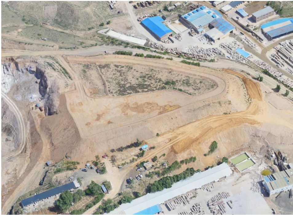
照片 3-16 1 号表土存放场
