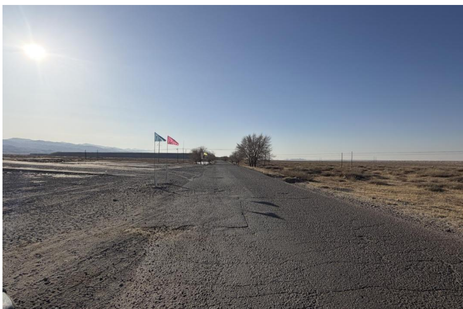
照片 2-24 沙公线柏油道路
