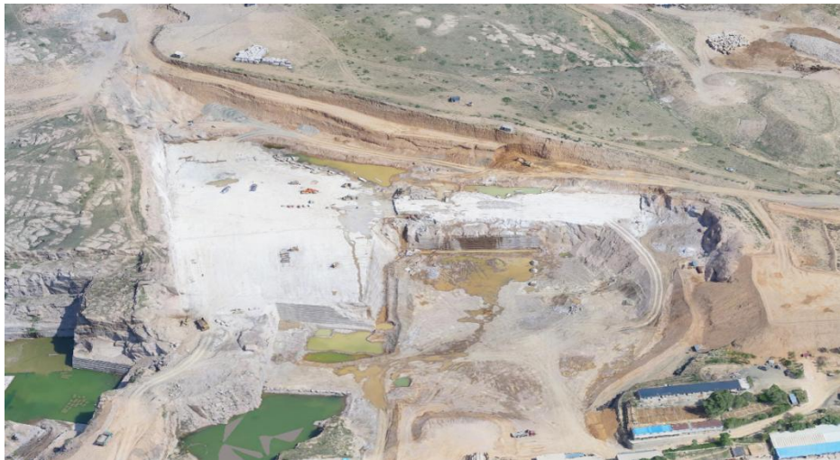
照片 3-7 CK4 采坑
