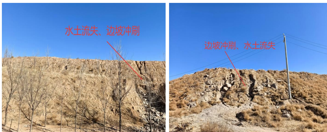
图 2-35 废石场边坡水土流失问题
