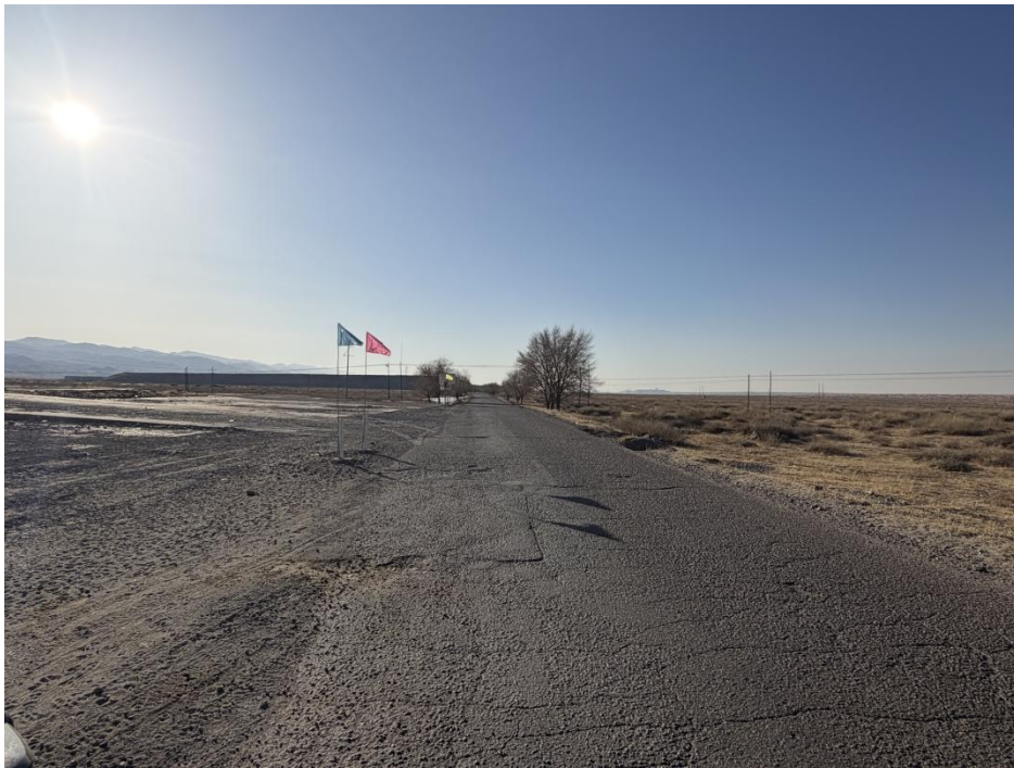
照片 2-29 沙公线柏油道路
