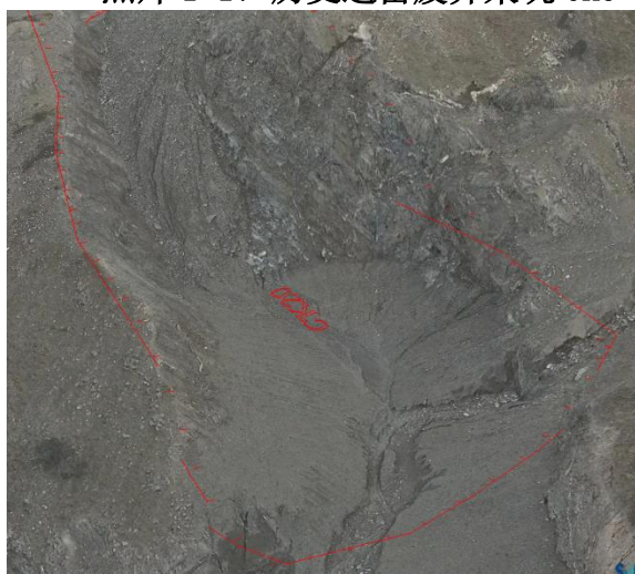
照片 1-19 历史遗留废弃采坑 CK7 9、废弃平硐 PD1 工业场地
