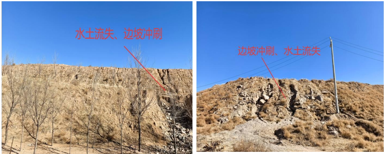
图 2-35 废石场边坡水土流失问题
