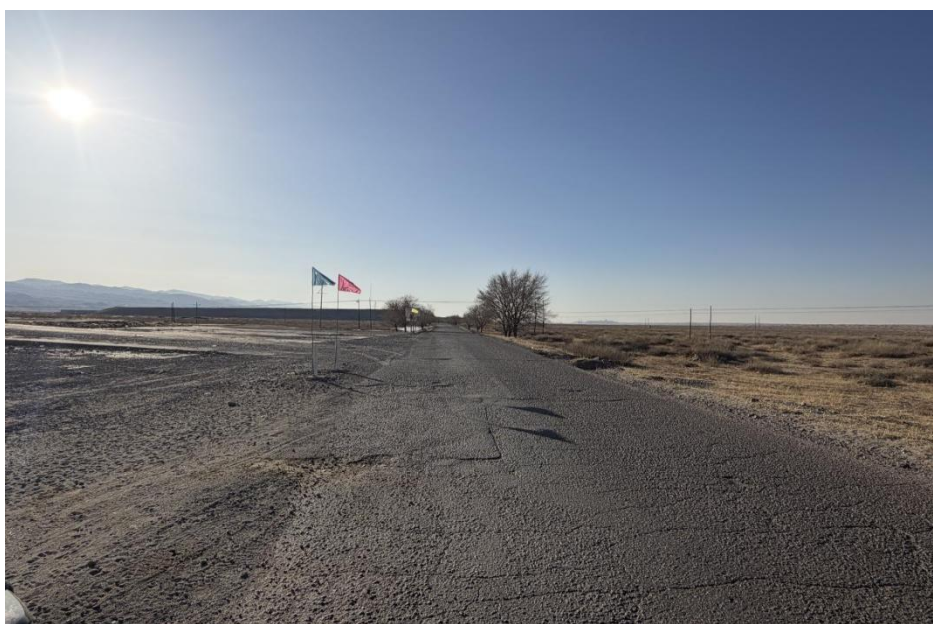
照片 2-24 沙公线柏油道路
