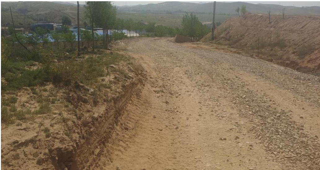
照片 3-20 矿区道路
