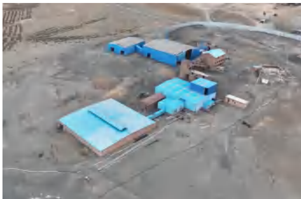
照片 1-19 选矿厂全貌
