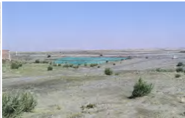
照片 3-18 停产后的尾矿库
