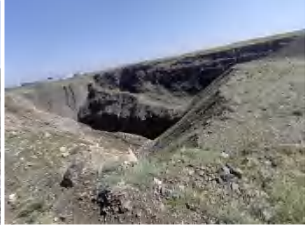
照片 1-2: CK1 未回填位置
