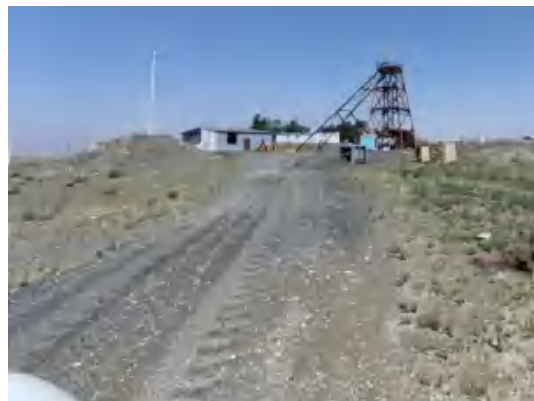
照片 1-23 矿区道路
