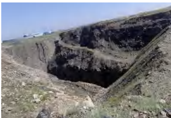
照片 3-2 采坑 3 坡面小规模崩塌
