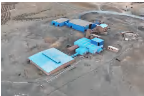
照片 3-15 选矿厂全貌
