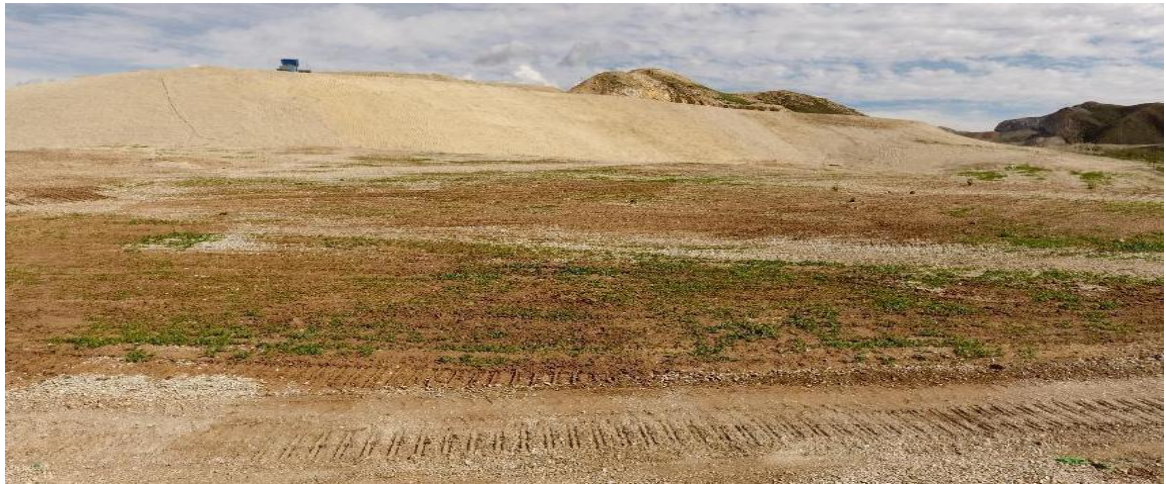
照片 2-9 晶牛料堆清理、边坡整形完成后 坡面播撒草籽
