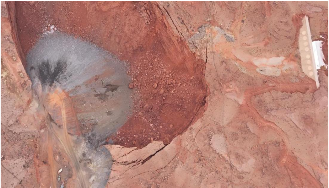
照片2-18 塌陷坑回填
