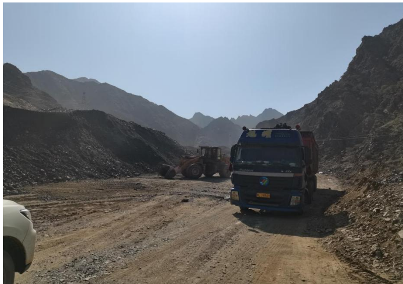
照片2-8 利用废石回填地表塌陷坑
