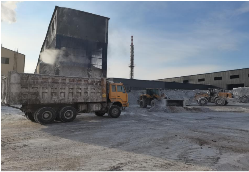
照片2-12 磷石膏回填塌陷坑运输中照片
