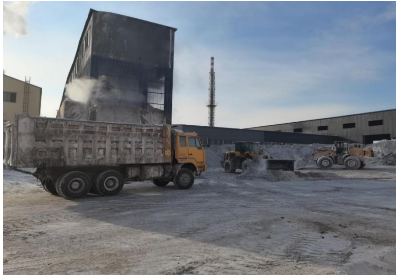
照片2-9 利用磷石膏回填地表塌陷坑
