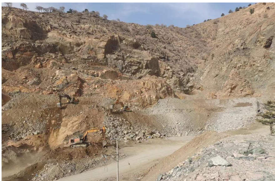
照片 2-2 一采区露天采场 CK2 北部回填治理效果
