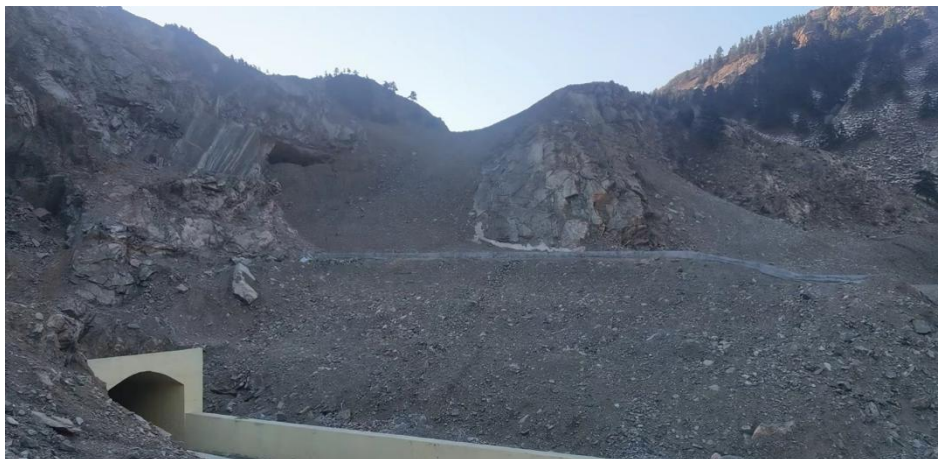
照片 2-1 一采区露天采场 CK1 北部回填、设置挡墙治理效果
