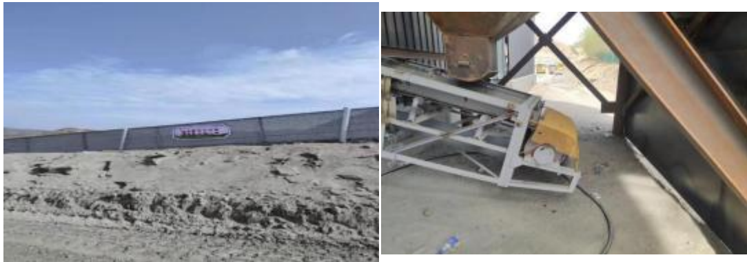
生产区皮带加装防尘网工程
