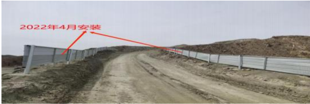
采区道路防尘网的加装工程
