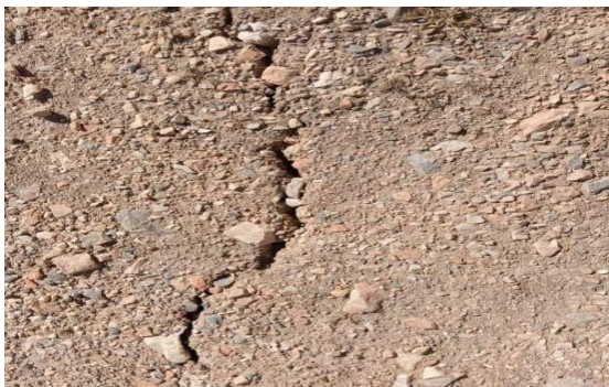
照片 2-15 二号采坑西侧边坡存在张裂隙治理前后对比照片
