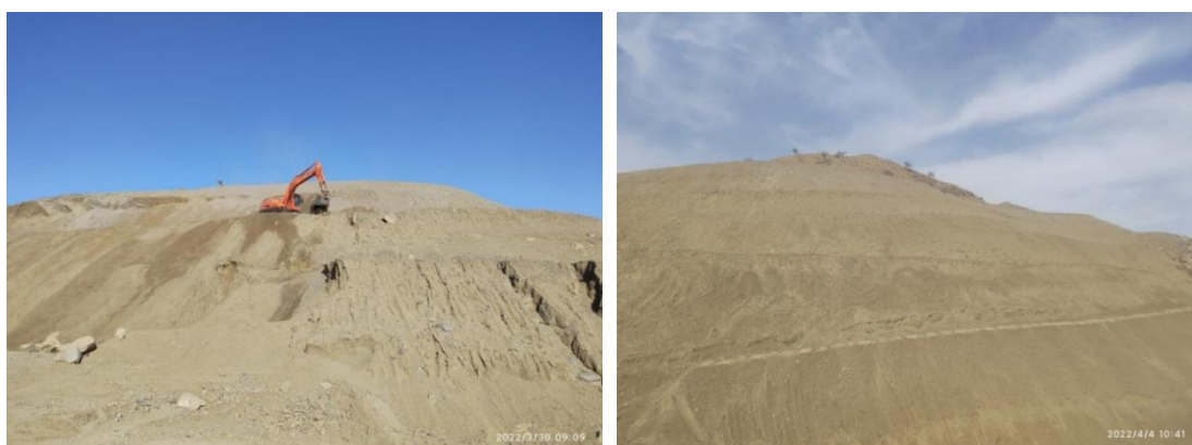
照片 2-2 废石堆边坡整形治理前后对比图
