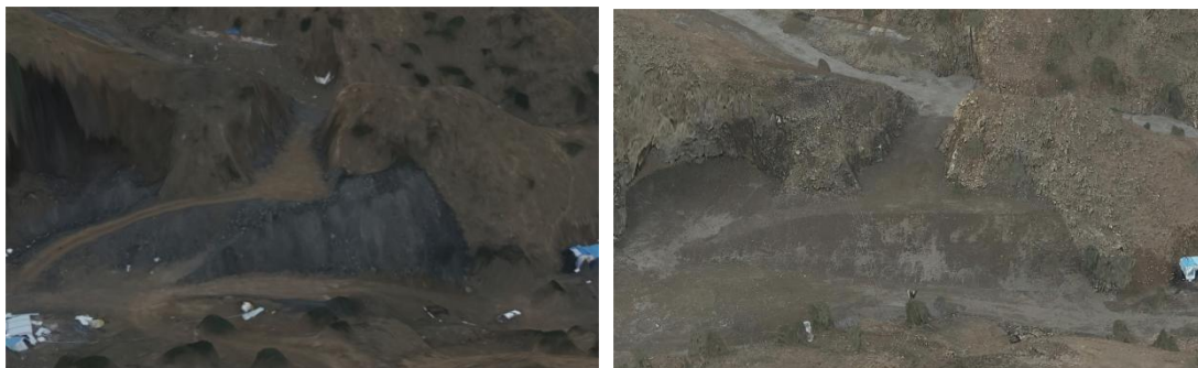
照片 2-8 路基垫坡、覆土、平整、恢复植被（治理前后对比图）
