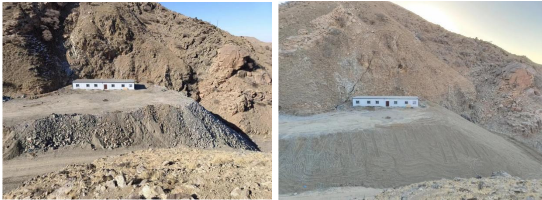
照片 2-10 边坡整形、覆土、平整、恢复植被（治理前后对比图）
