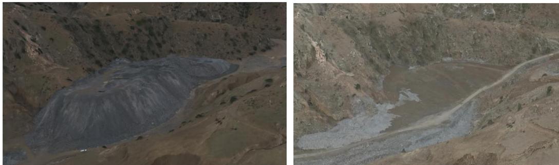
照片 2-11 废石堆清运、覆土、平整、恢复植被（治理前后对比图）
