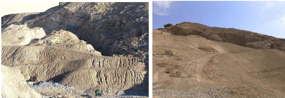
照片 2-2 采坑回填、覆土、平整、恢复植被（治理前后对比图）
