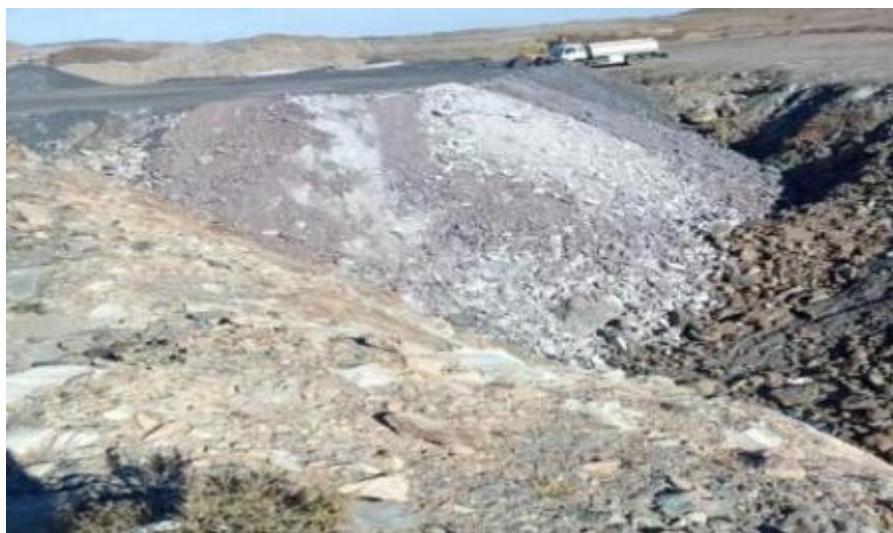
照片 5-1 正在废石回填平整治理的采坑照片
