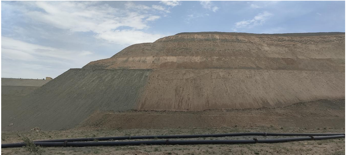
照片 3-5 废石场南部边坡（已平整分台阶，降低了边坡坡度，部分地段已覆土）
