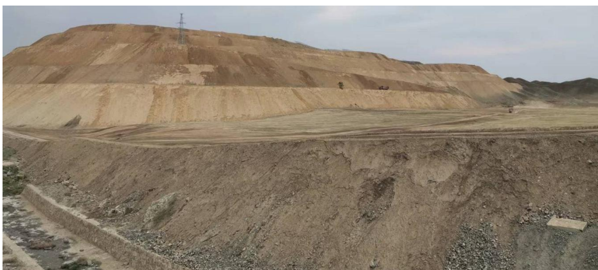
照片 3-4 废石场东部边坡（已平整分台阶并覆土）
