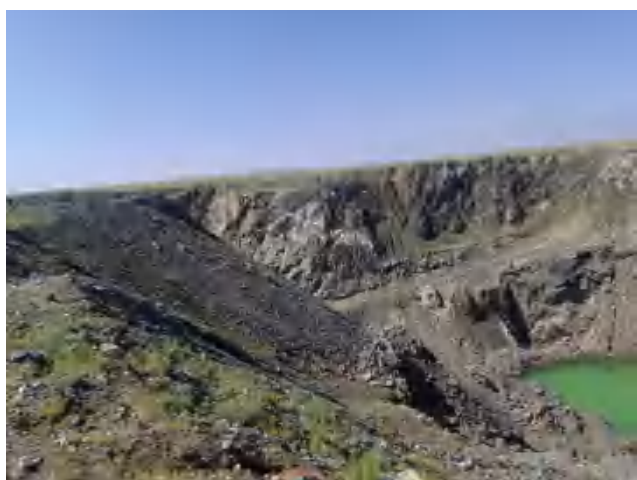
照片 3-1 采坑 1 坡面小规模崩塌
