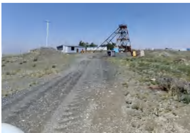
照片 2-15 矿区内道路
