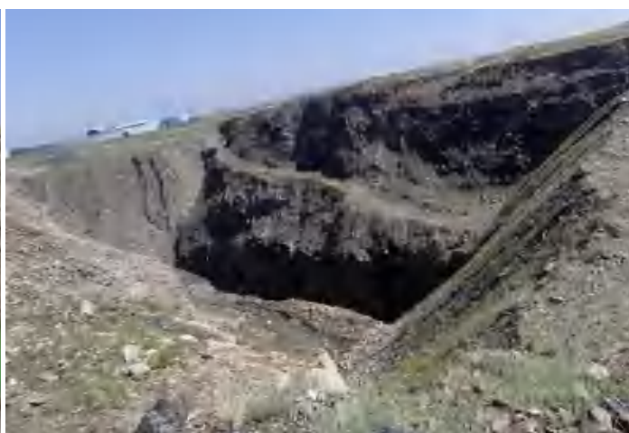
照片 3-2 采坑 3 坡面小规模崩塌
