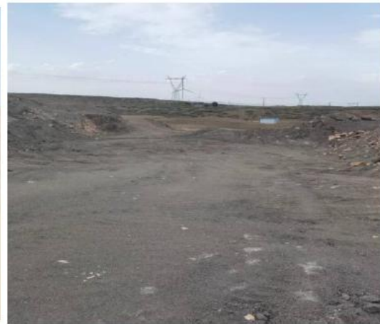
露天采坑坑底治理后
