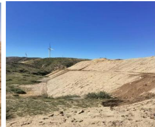
废石堆 2 南侧边坡治理后
