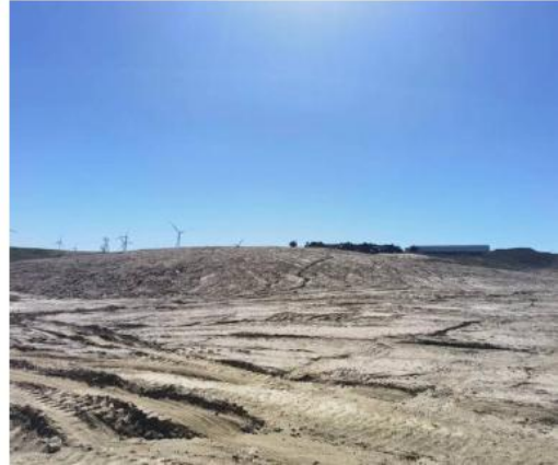
废石堆 3 堆顶治理后
