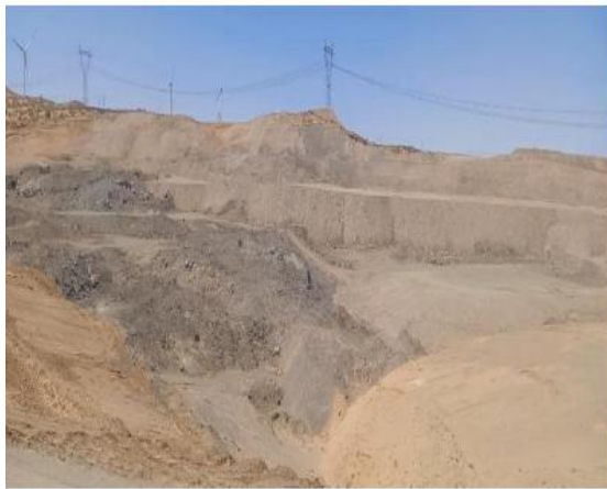
露天采坑坑底治理前
