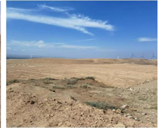
废石堆 4 堆顶治理后
