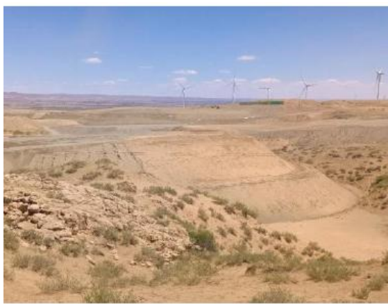
废石堆 2 南侧边坡治理前
