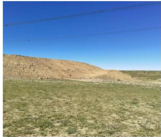
废石堆 1 北侧边坡治理后
