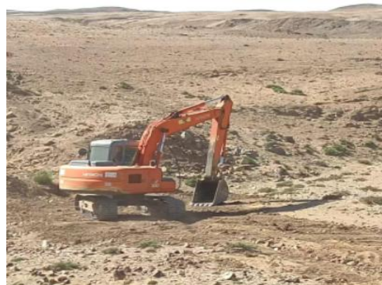
照片 2-12 探槽治理后(回填、平整、覆土)
