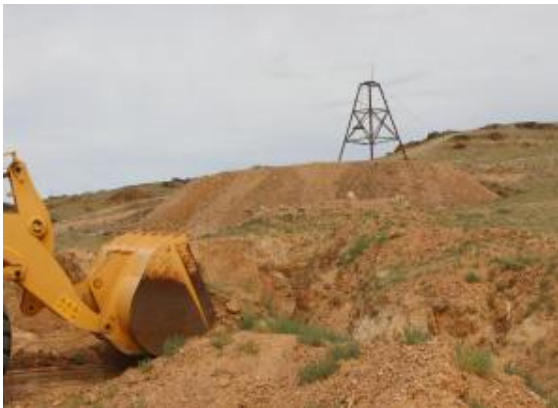
照片 2-5 部分回填后的探坑
